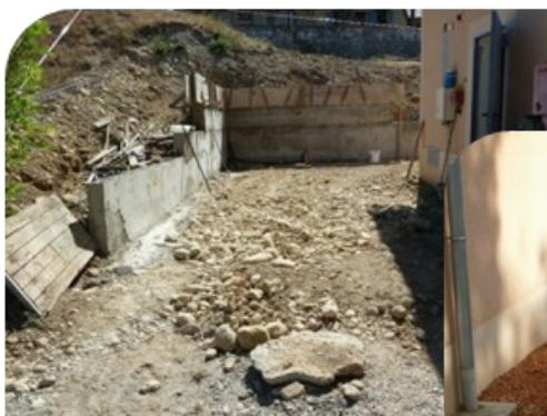
Réfection côté droite SP + construction du mur de soutènement.
